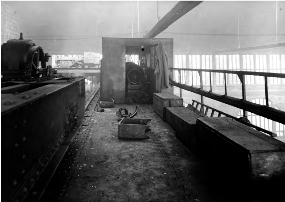
Le pont roulant du bâtiment G des Batignolles après le sabotage - photo de la police (ADLA)
